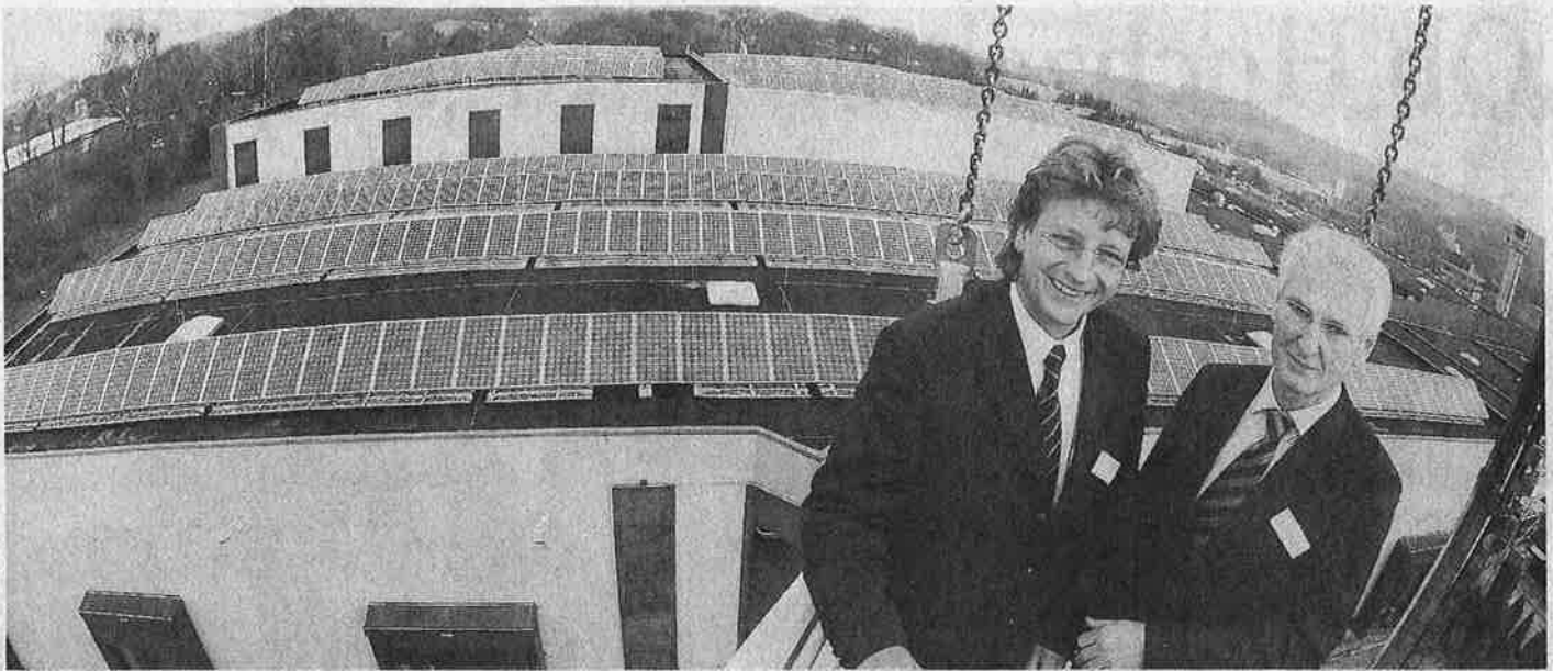
Vor dem größten Solardach im Bergischen Land: Hans-Wilhelm Peters (rechts) und Stefan Söhn von der Firma Toplog.
