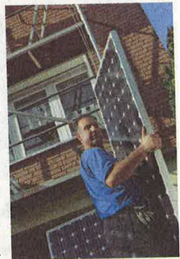
Milazim Rutke: Vom »Bau-Allrounder« zum Solar-Facharbeiter
