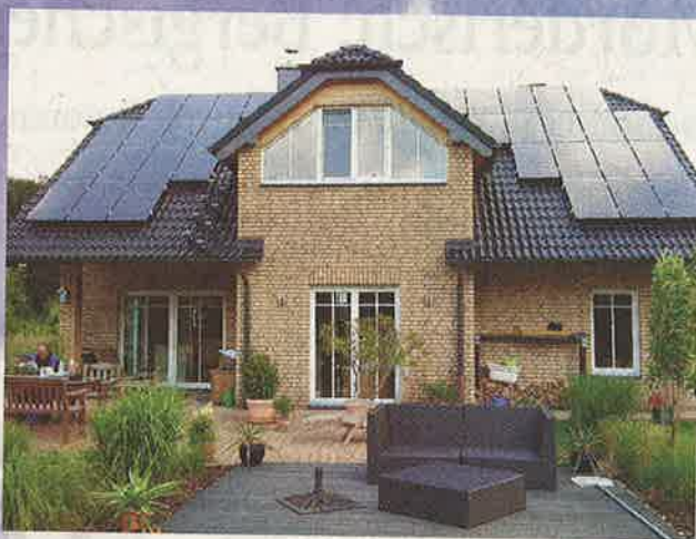
Photovoltaik-Anlage mit 5,280 kWp
