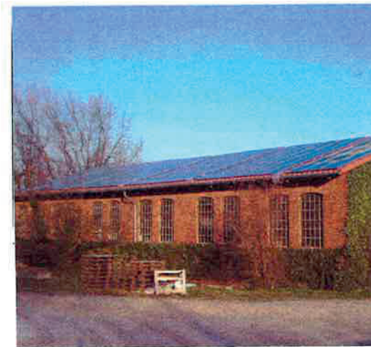
■ oben: Steildach Photovoltaiksystem Golfclub Hubbelath
