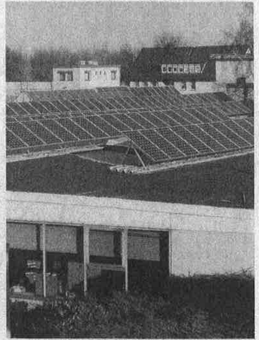
Photovoltaik-Anlagen werden üblicherweise auf den Dächern installiert.
